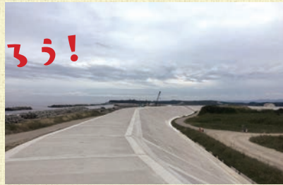
塚原の海岸で整備が進む防潮堤 (2018年9月撮影)
